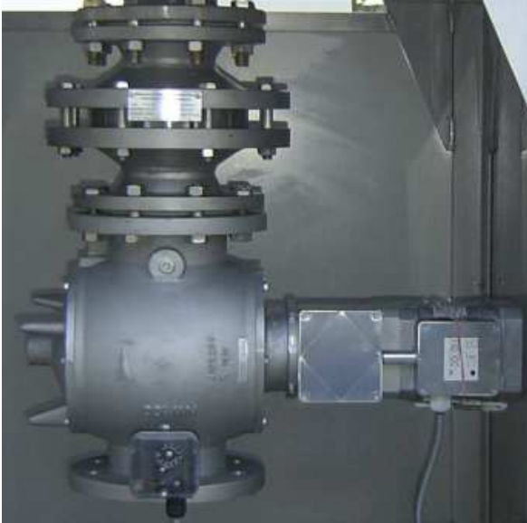
Abb. 7. Flammensperre und Hauptgasventil
